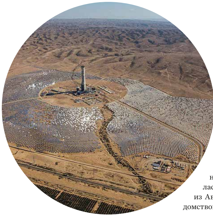
Электростанция в Негеве. Революция начинается в пустыне?
