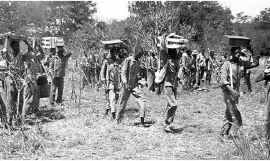
Начало большого похода
